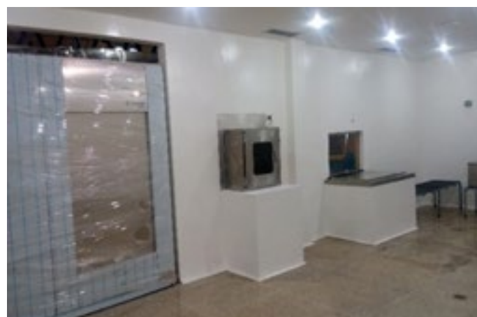
Figura 15. Autoclave Doble Puerta y Esclusa
